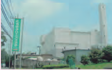
とちぎクリーンセンター
